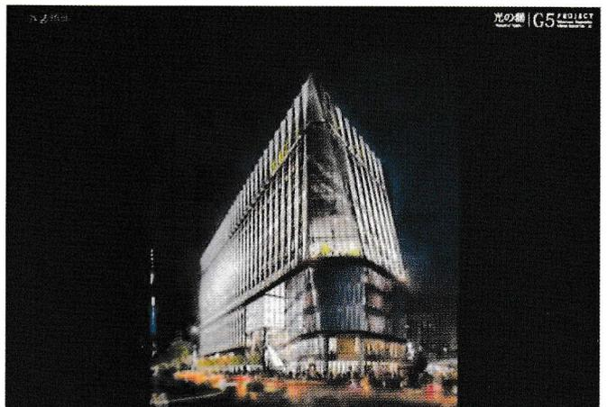
技術的には光の協奏を実現するに当たり、テナントの光を透過しながら外装照明の光の輝度を確保することが求められました。外装照明の光が強すぎるとテナントの明かりが見えず、またテナントにも影響を与えてしまいます。逆に、外装照明の光が弱すぎると、ただテナントの光が漏れるだけになってしまいます。外装照明についても、何度も銀座デザイン協議会様とやりとりをさせていただき、さまざまなご意見をいただいた上で、今の外装照明が完成しました。
