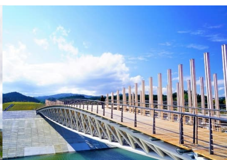
③南三陸町震災復興祈念公園・中橋
