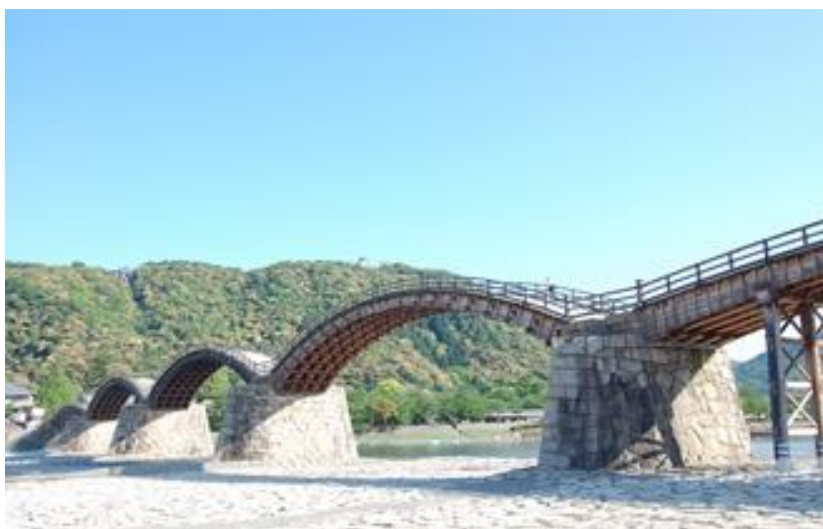
岩国市 錦帯橋
