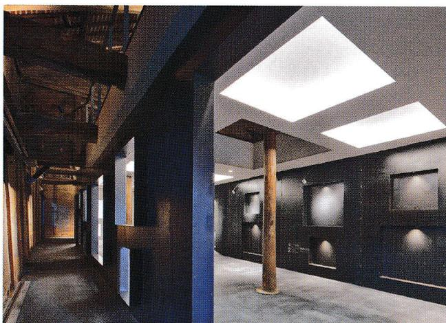
回廊とギャラリー／梁の下に新たに黒皮鉄板を挿入することで構造補強
