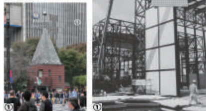
れんがパネル工法 (①板壁 ②型枠打込み)
