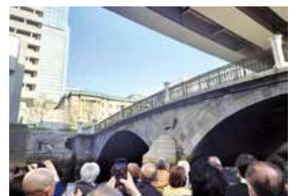
常磐橋と日本銀行と高層ビル
