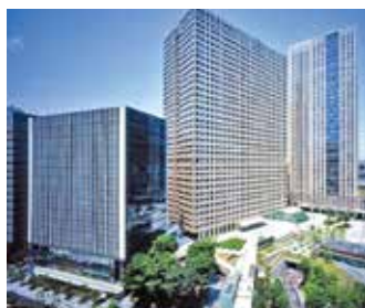
東京倶楽部ビル、霞が関ビル+霞テラス ※
