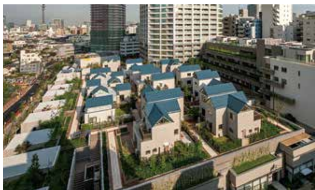
西富久再開発のペントハウス住宅
