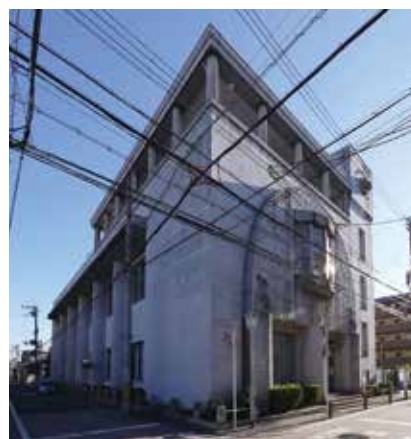
北東外観 3階列柱内には木造の柱がある
