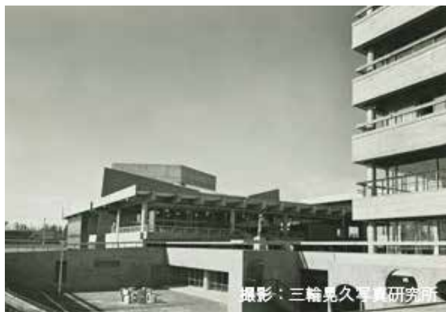
図6 三鷹市庁舎・議事堂・公会堂（1965）
