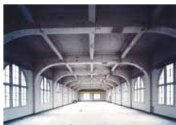
3F 自動交換機室アーチのハンチデザイン
