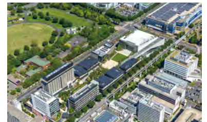
街区全体を見下す。1 階に駐車場を集約し、2 階の人工地盤面の中央に約 1ha の広場を設け、各棟はそれを囲むように配置
