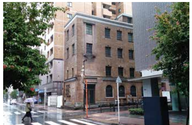
昭和4年築の旧相互無尽本社ビル。ギャラリーのある神保町さくら通りのランドマークでもあった
