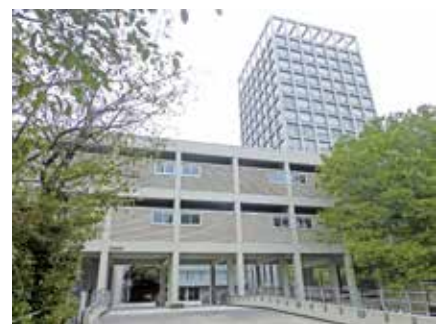
戸山キャンパス 31 号館、奥に新 33 号館
