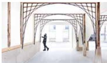
細い網のような門型の鋳鉄耐震補強フレームにより「抜け」のある空間を作り出す
