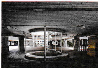
アトリエ棟 (1964年) : 1階ピロティ
