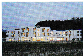
川越しに見るエントランス側外観(夕景)
