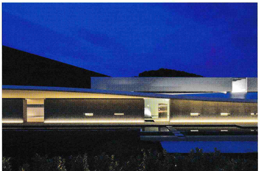
撮影：小川重雄写真事務所 小川重雄
