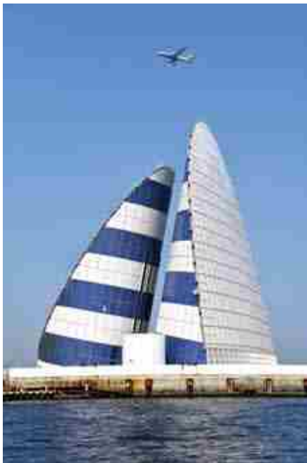
「風の塔」1997年。東京湾アクアライン、浮島人工島。鉄骨・セラミック貼
