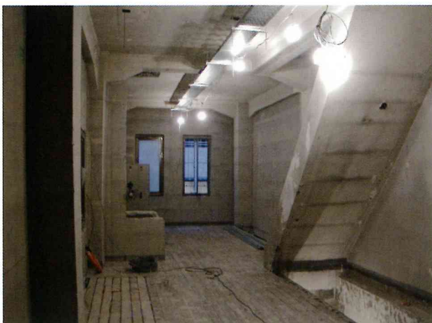
改装前の倉庫の状態
