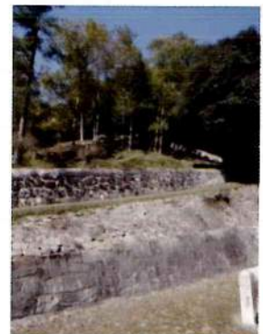
閑谷学校 野石積の土留
