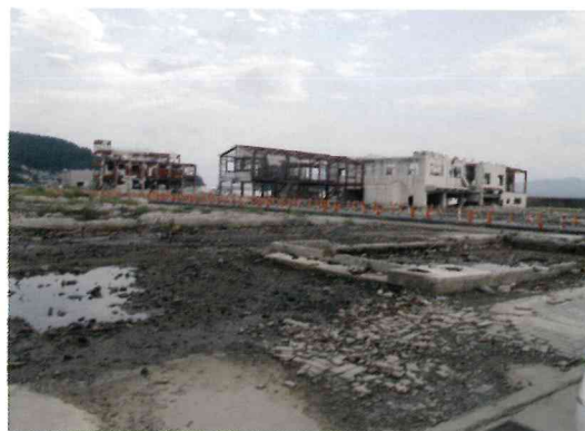
津波により破壊された市街地
