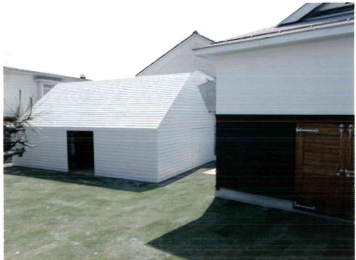
(撮影 広川智基)
