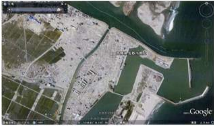
↑ 関上地区 被災後空撮
