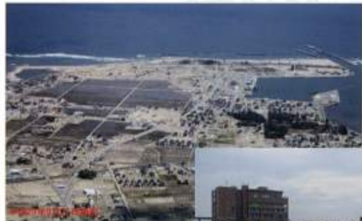
↑ 荒浜地区被災後
