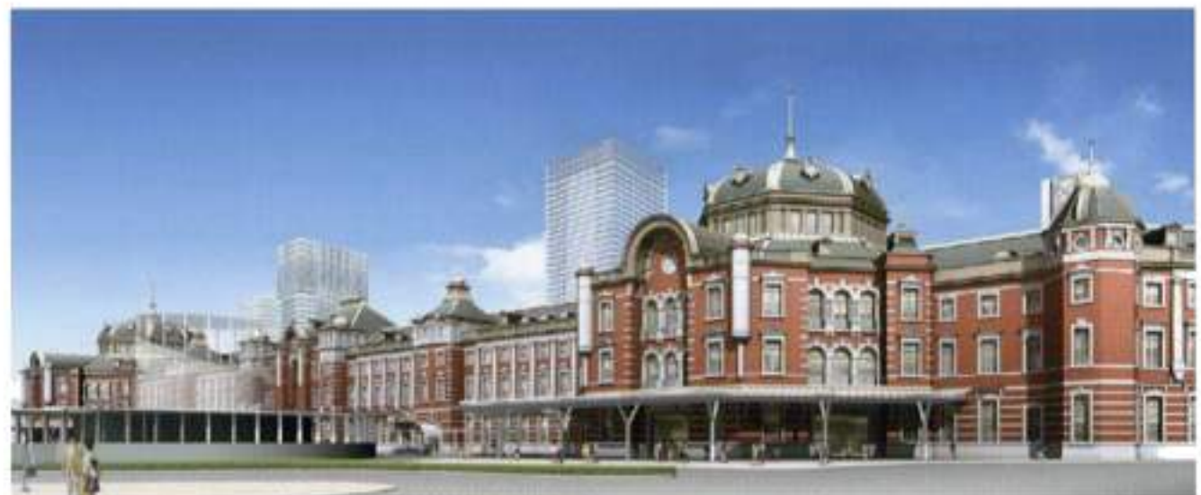
東京駅丸の内駅舎保存・復原工事
