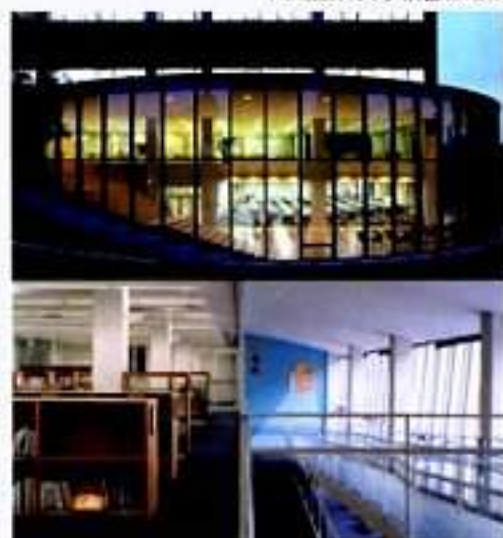
坂駅南口複合施設
