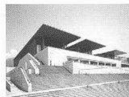
海側階段広場
