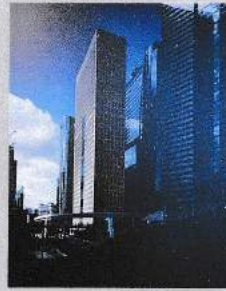
鹿島建設(株)設計 エンジニアリング本部 北 典夫 汐留タワー
