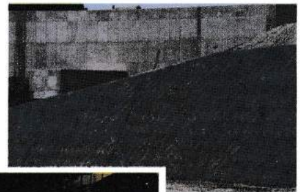
色彩開発した手前のブロックと後部のコンクリート打ちの色合いの相違
