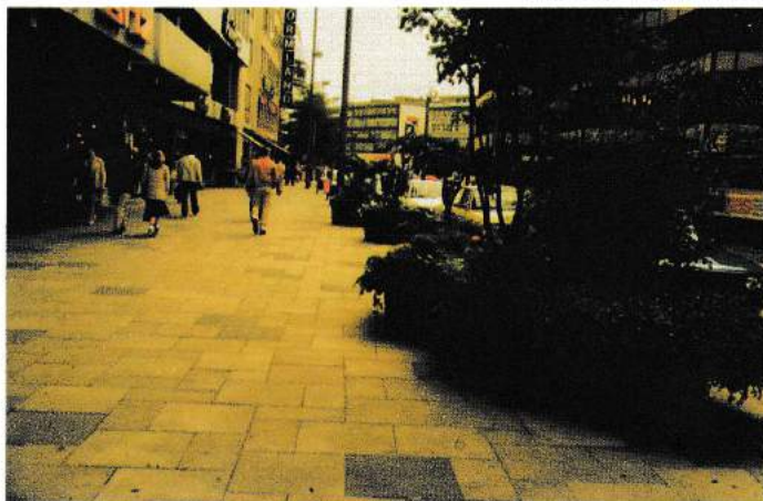
色彩開発した手前のブロックと後部のコンクリート打ちの色合いの相違
