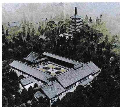
京都醍醐寺伝法学院施工中
