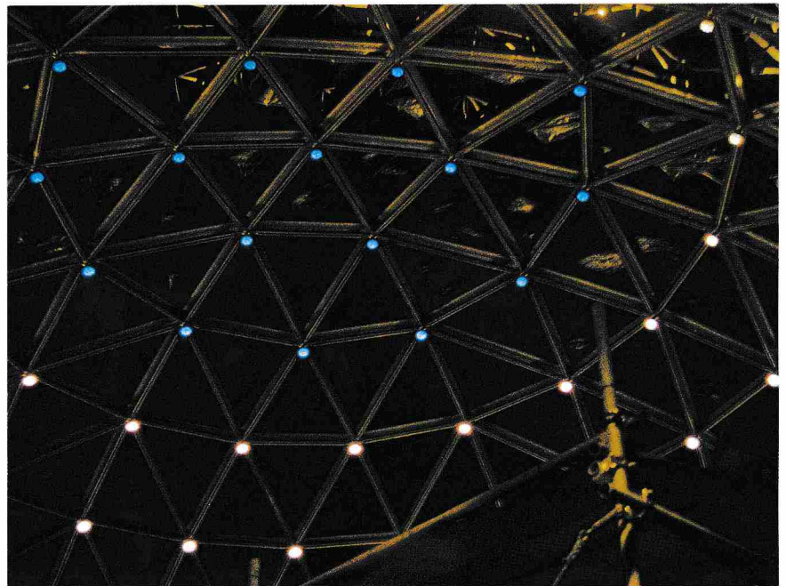
千葉東口駅前広場ドーム
