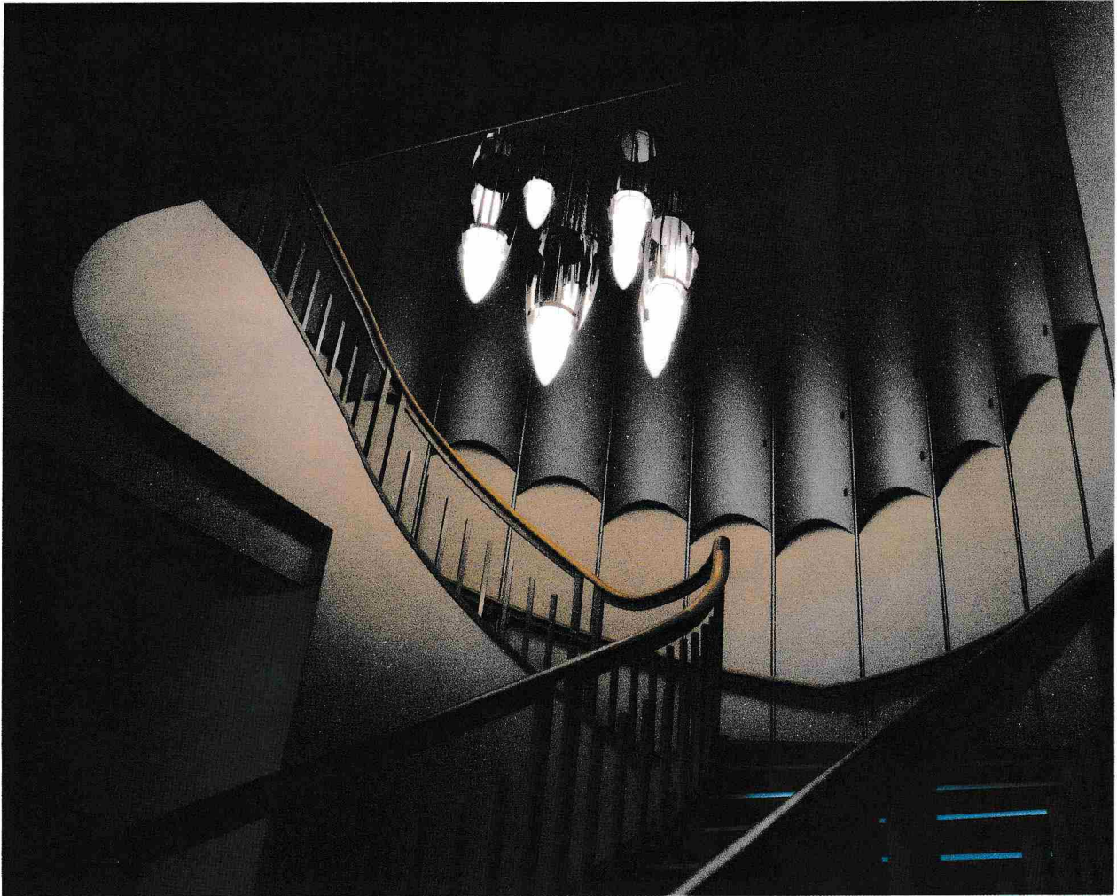
壁(アルミ オプティックフレア塗装) 階段手摺(スチール アクリルウレタン樹脂塗装)
