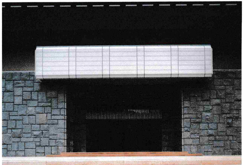
バルコニーパネル(アルミキャスト アクリルシリコン樹脂塗装) 縦格子(アルミ アクリルウレタン樹脂塗装)
