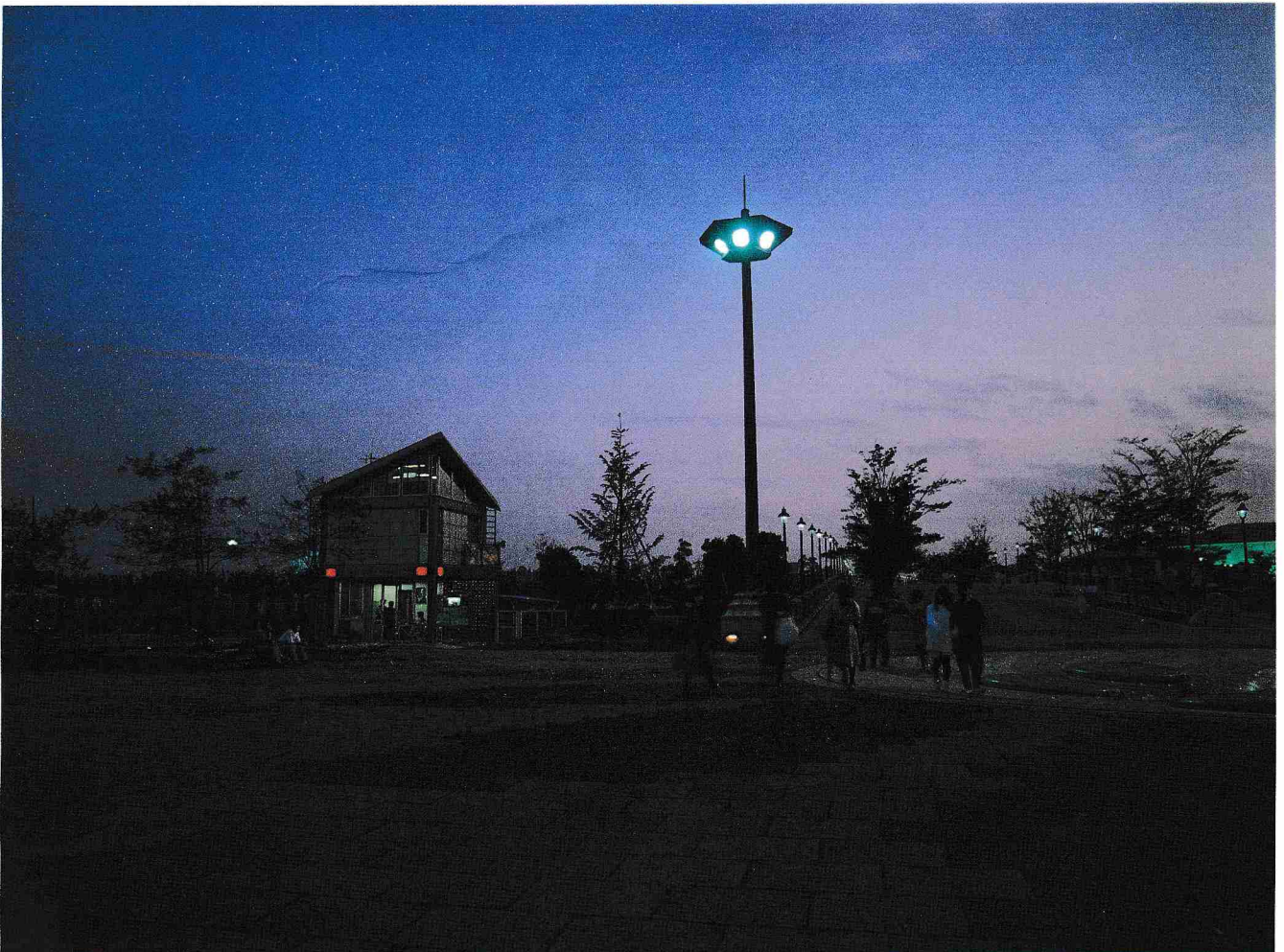
葛西署 臨海公園派出所 (平成元年)
