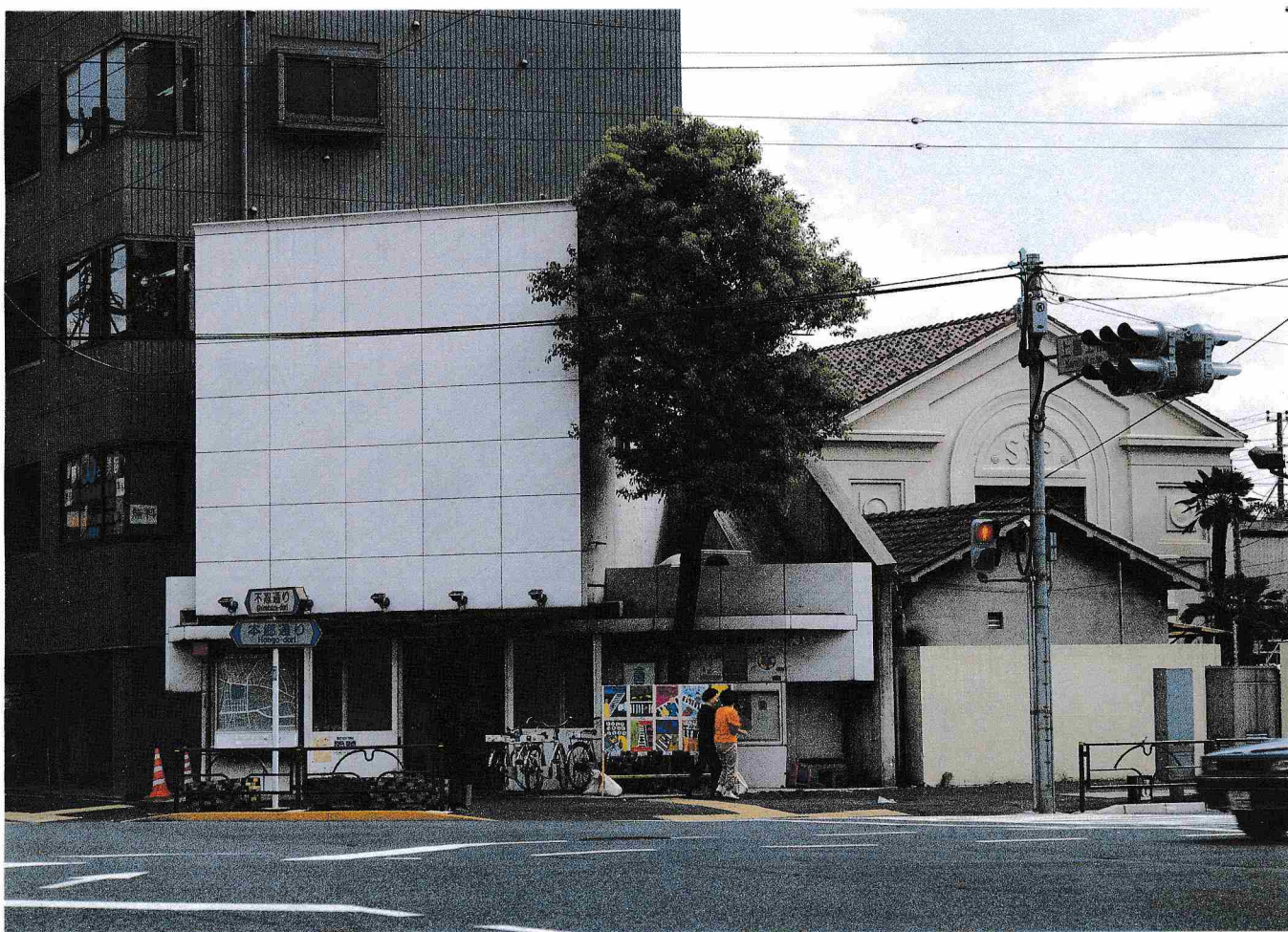
駒込署 上富士前派出所 (昭和62年)
