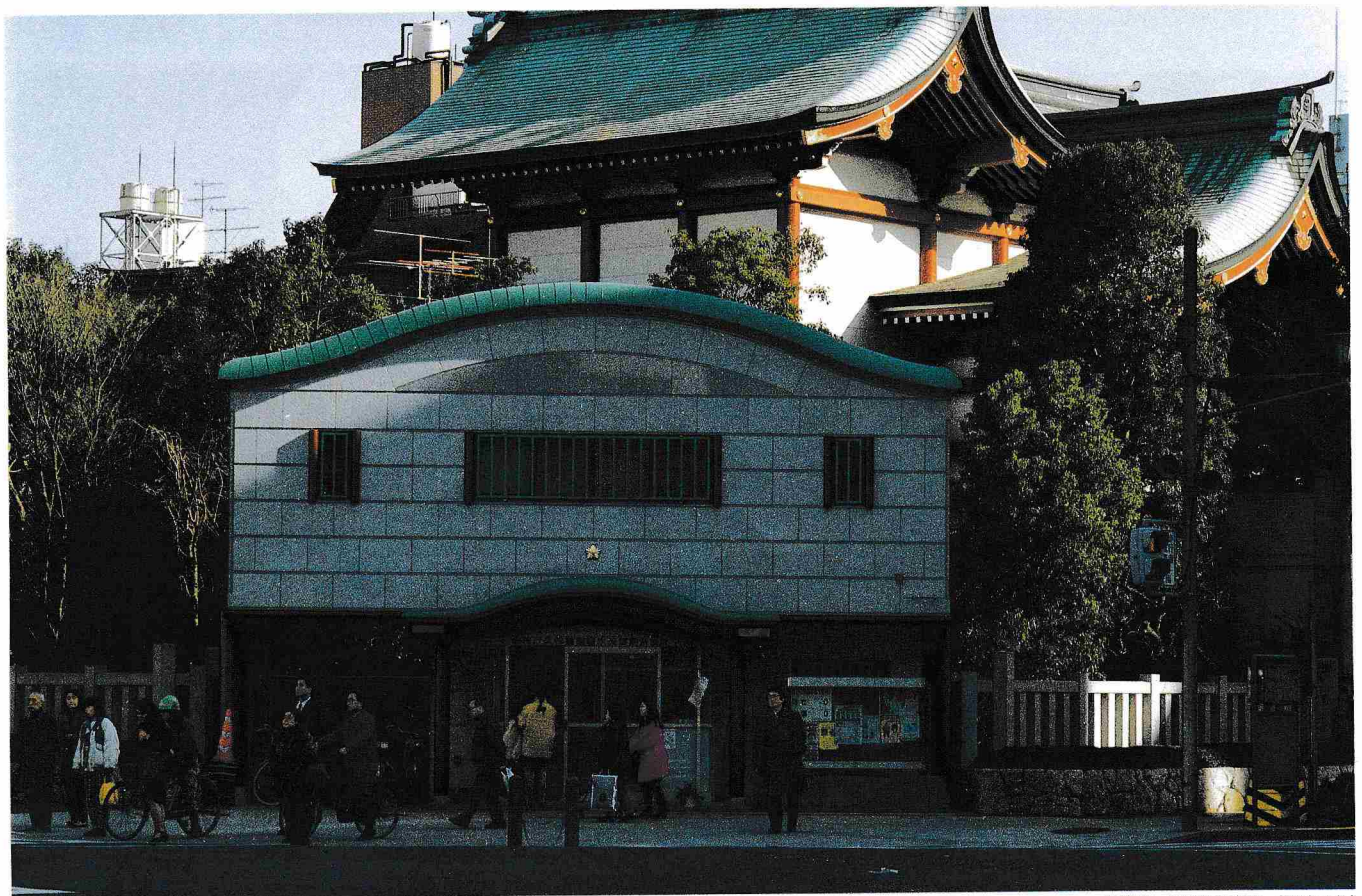
久松署 水天宮派出所（平成4年）
